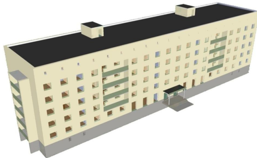
Общий вид до реконструкции
